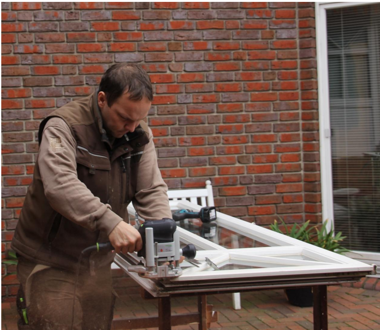
Hier fräst Tischlermeister Stephan Ankert die Beschlagsnut am Fenster für bessere Beschläge nach
